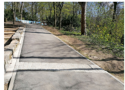
Der Weg am Bergspielplatz wurde neu asphaltiert und längs durch Mulden ergänzt
