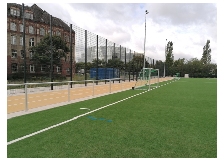
Der erneuerte Sportplatz an der ehemaligen Teske-Schule
