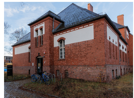
Das Haus am Werner-Voß-Damm
