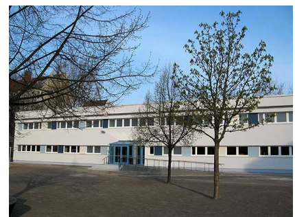
Die sanierte Sporthalle auf der Schulhofseite
