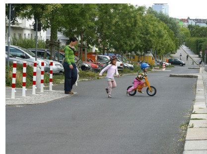
Gehwegvorstreckungen erleichtern allen das Queren der Fahrbahn
