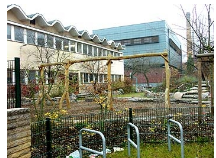
Die kleine Sporthalle vor der Sanierung
