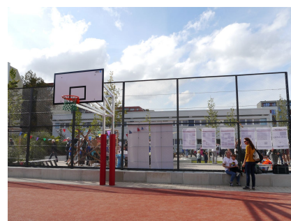
Zu den Außenanlagen der Schule gehört nun ein gut ausgestatteter Basketballplatz
