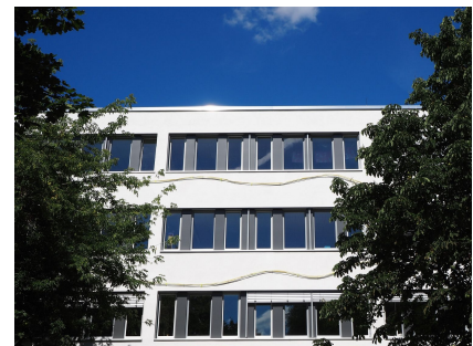
Die Südfassade nach Fertigstellung 2015
