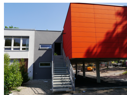
Die Gebäudeverbindung zur benachbarten Kita
