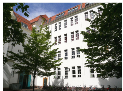
Der denkmalgerecht sanierte Innenhof
