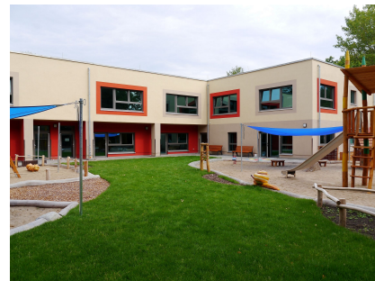
Zur neuen Kita gehört eine großzügige Freifläche
