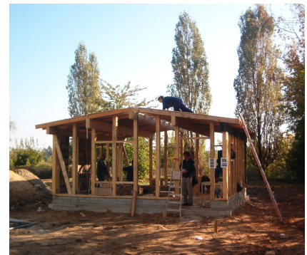
Die Ökoloabe im Bau
