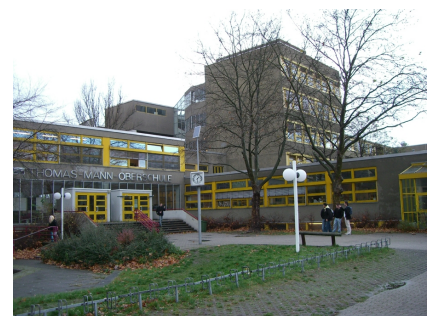
Die Thomas-Mann-Oberschule vor Projektbeginn mit zweigeteiltem Haupteingang
