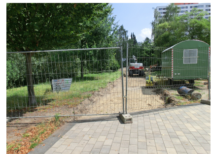
Baustelle im Sommer 2014
