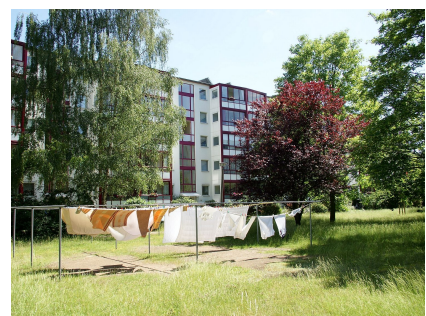
Großzügige Innenhöfe nördlich der Michelangelostraße
