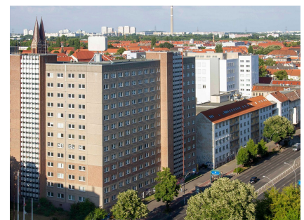
Blick auf den abgeschirmten Block an der Frankfurter Allee
