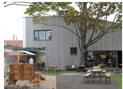
Das Gebäude ragt über die Mauer des Betriebshofes der BVG
