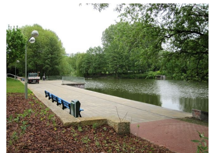
Auch die Wasserterrasse wurde saniert
