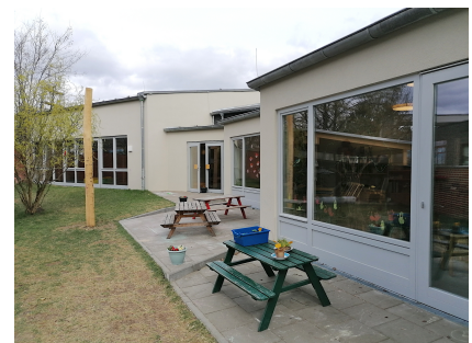
An den ehem. Gemeindesaal wurden die neuen, wabenförmigen Gruppenräume angegliedert
