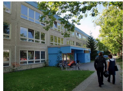
Das Gebäude vor Projektbeginn
